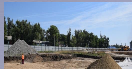
Рис. 30 - Строительство Ледового дворца
